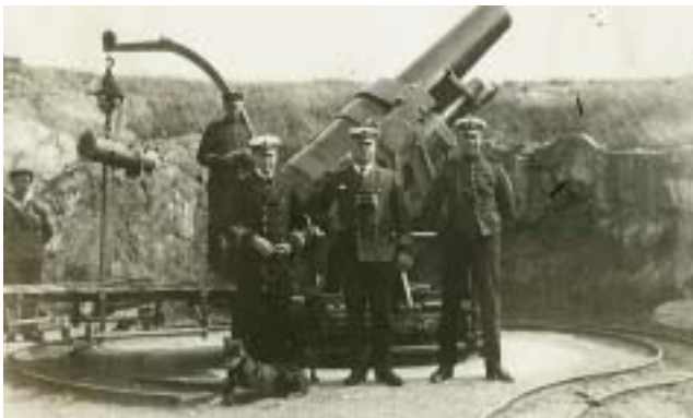
Batteri Stenbrottet på 1920-talet
